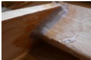
Fabrication d'un joint congé de liaison entre l'aile et les porte-roues.
